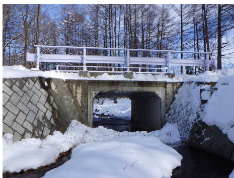
写真1. 橋梁架け替え例 中の沢2号橋 (ボックスカルバート)
