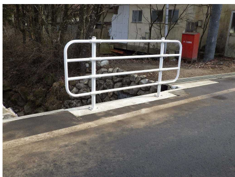
写真3. 高欄補修例 矢出川2号橋 (高欄更新)
