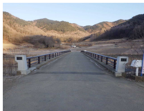
写真2. 橋面補修例 向橋 (舗装更新)
