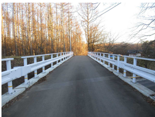
健全度Ⅰ：板橋国道橋
