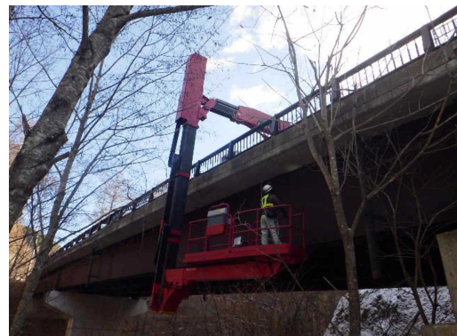
写真2. 橋梁点検車による点検
