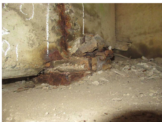
健全度Ⅲ：平沢橋
