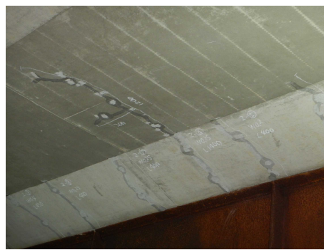
写真4. 床版補修例 板橋東大橋 (ひび割れ注入)
