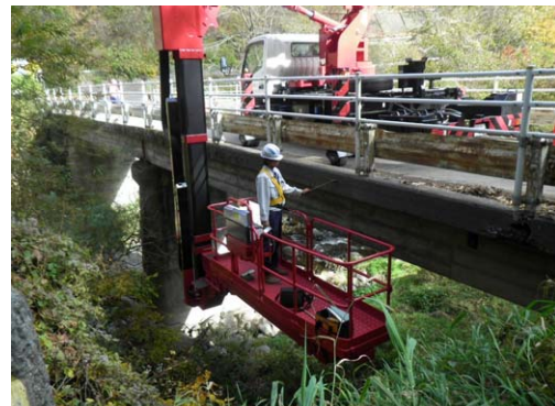
写真 2. 橋梁点検車による点検
