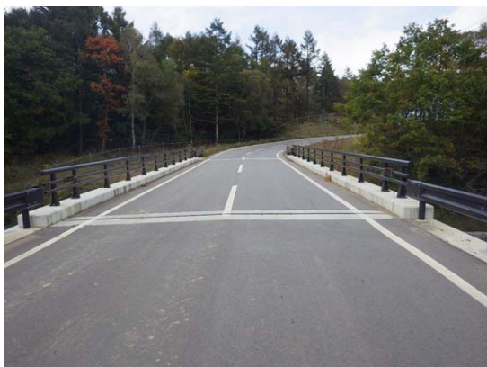
健全度Ⅰ：茶堰橋
