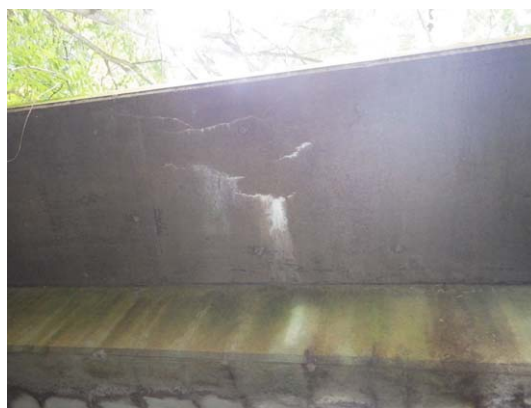
健全度Ⅱ：高見沢 5 号橋
