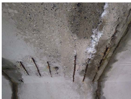
健全度Ⅲ：丸山 4 号橋
